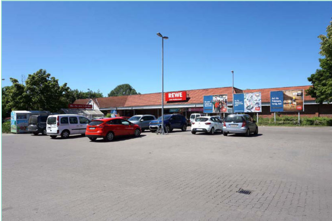
Abb. 3: Falkenthaler Chaussee 57 in der Stadt Zehdenick: Die Fläche des BPlans „Nahversorgung Falkenthaler Chaussee 57“ ist bereits bebaut und zu einem großen Teil versiegelt.
