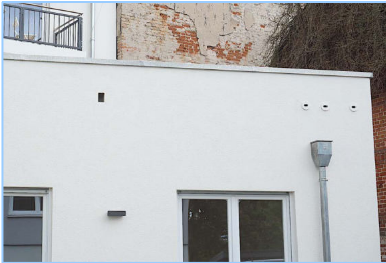
Abb. 25: Integration von einem Mauerseglerkasten 17A, dreifach und einer Halbhöhle 1HE für Hausrotschwänze in einen Neubau. Tino-Schwierzina-Str. 5 in Berlin-Heinersdorf, 2021.
